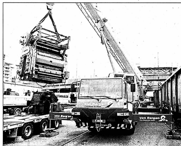
Ce qui est devenu un tas de ferraille de plus de 100 tonnes a nécessité trois convois de camions, chargés hier et aujourd'hui pour gagner la gare aux marchandises.
