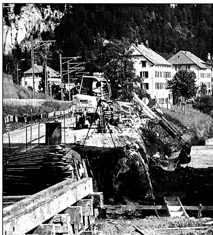
L'ouvrage sera rattaché au mur de soutènement existant. PHOTO DE CRISTOFANO
