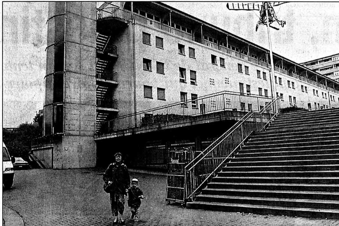
L'école primaire des Acacias, à Neuchâtel, un exemple d'utilisation des énergies renouvelables, avec l'installation notamment de capteurs solaires.
