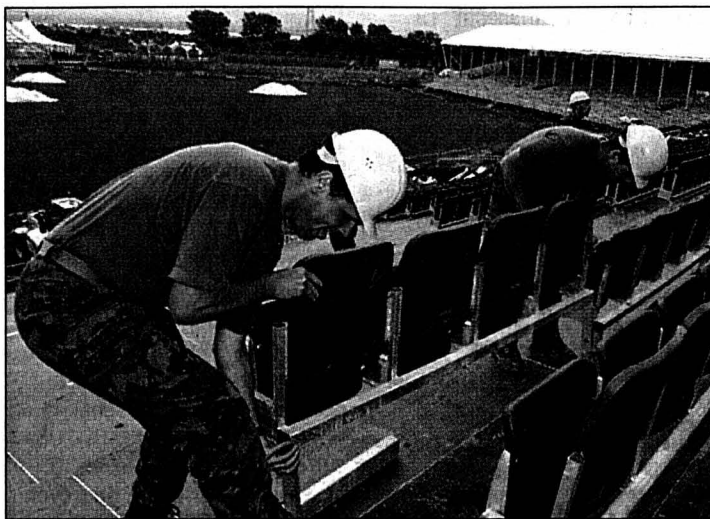
L'armée participe à la construction de l'arène à Nyon.
