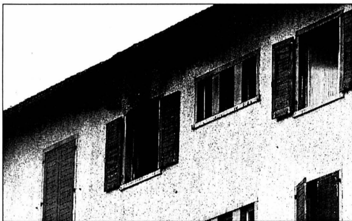
Au 4e étage de l'immeuble, un appartement a été détruit par le feu.
