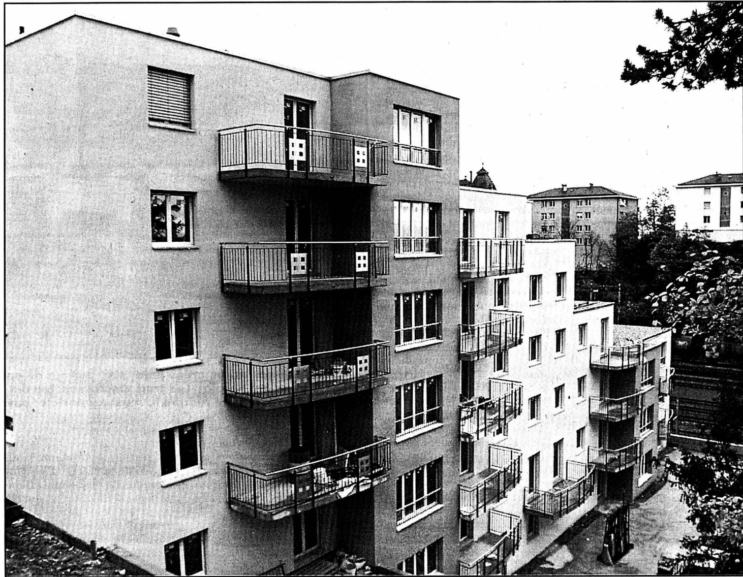
La façade sud-ouest de l'immeuble.
