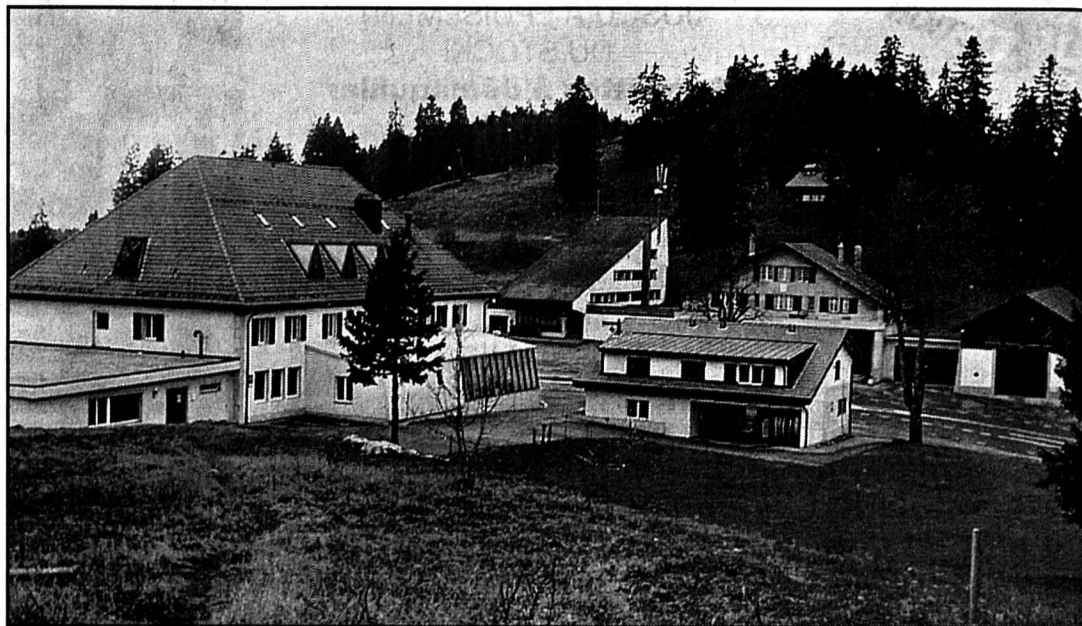
Le complexe hôtelier de La Vue-des-Alpes, relié à la station d'épuration de La Rincière, atténuera les hausses projetées à Fontaines pour financer les charges de l'épuration des eaux usées.
