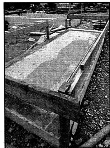
La trappe d'une sortie de secours, au Jardin anglais. photo Marchon
