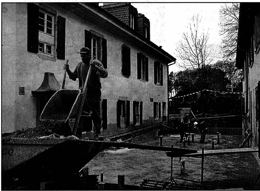
Le gros œuvre (aplanissement des niveaux et construction du toit reliant les deux corps de bâtiment) devra être achevé avant Noël.
