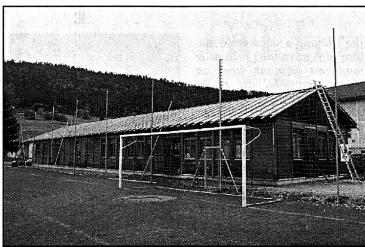
La construction des nouveaux vestiaires du FC Couvet est déjà bien avancée. photo Marchon
