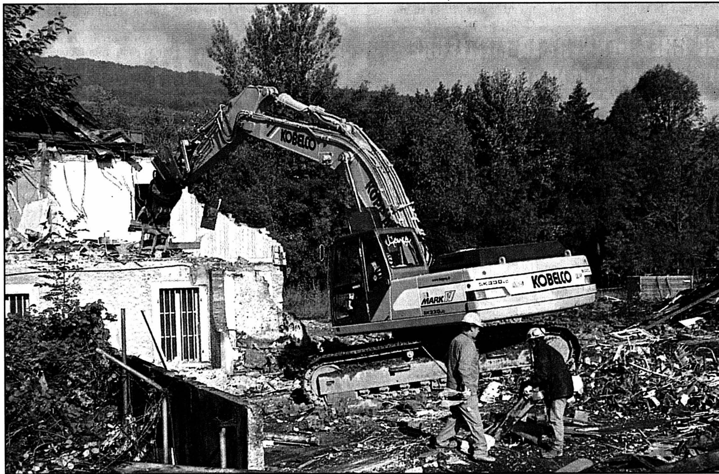
Les travaux, hier, sur l'exoparc d'Expo.02 à Bienne.
