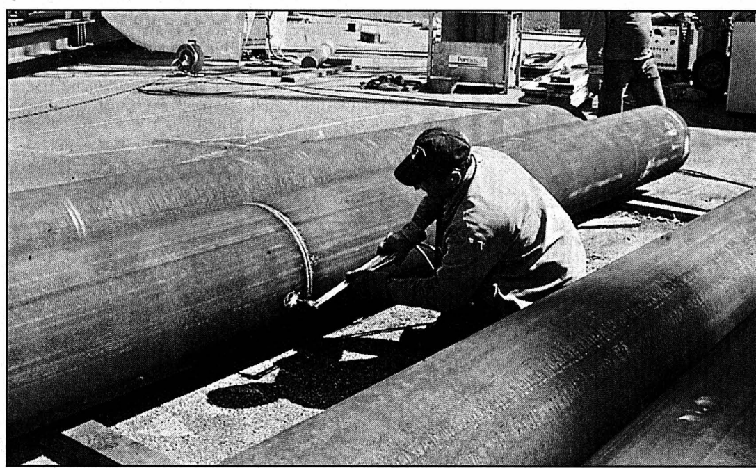
Les 64 pieux soutenant les galets du forum seront contrôlés jusqu'à mi-novembre.
