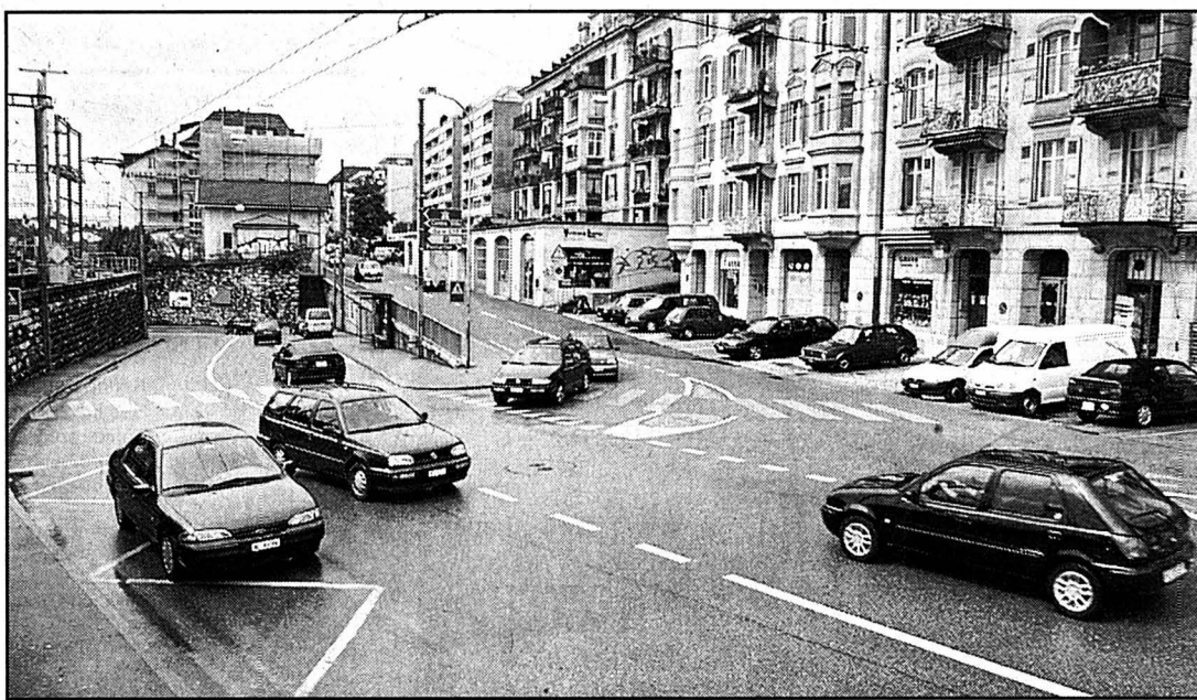
La première phase de la transformation du carrefour Sablons/faubourg de la Gare ne devrait pas entraîner d'importantes perturbations. photo Galley
