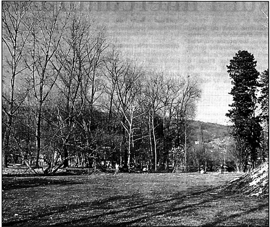
Après trois ans de tribulations autour du nouveau bâtiment du Centre d'animation et de prévention, une seule chose est sûre depuis jeudi soir: il sera construit sur le terrain des Français. photo a
