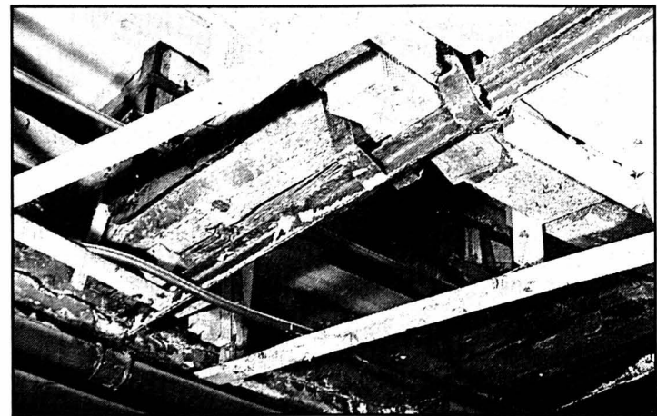
Manifestement, le mariage du bois et du métal n'a pas été maîtrisé.
