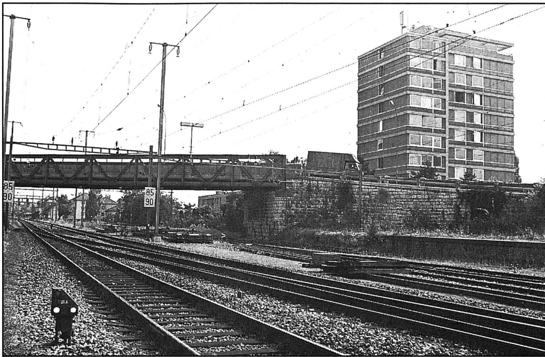
Le pont de Beauregard, ainsi que 80 mètres de chaussée, devront être surélevés de 60 centimètres au maximum. photo Marchon
