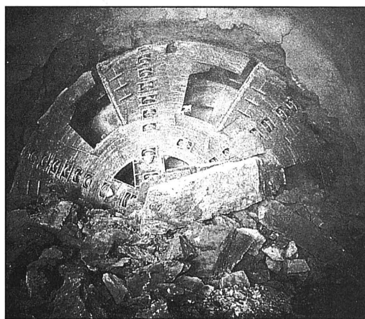
Parti de Chassagne en juin 1998, le tunnelier est réapparu hier dans le vallon du Pontet, dans les temps.
