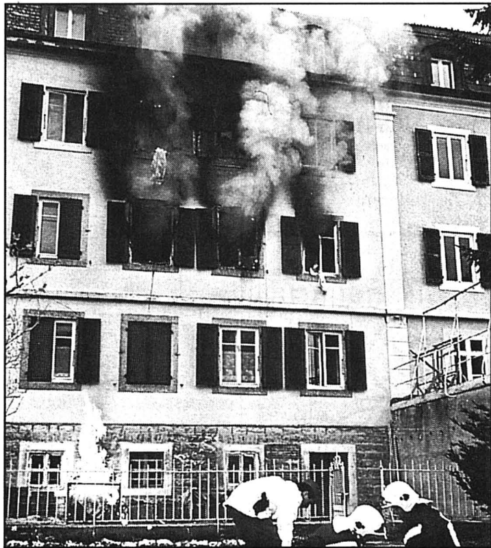
Côté sud, les flammes léchaient la façade jusqu'au toit. Impressionnant.
