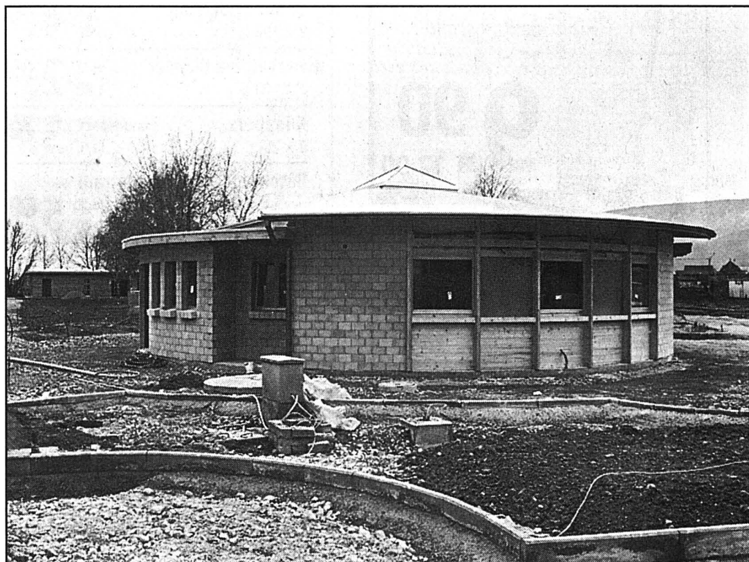
Le bâtiment circulaire de la future réception avait dû être érigé sous tente pour éviter de cumuler les retards dus aux intempéries. photo Marchon
