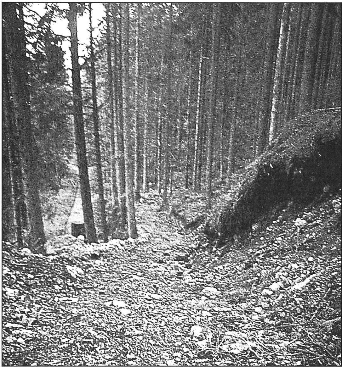
L'une des deux dessertes aménagées par la commune de Boudry dans la réserve du Creux-du-Van. photo sp
