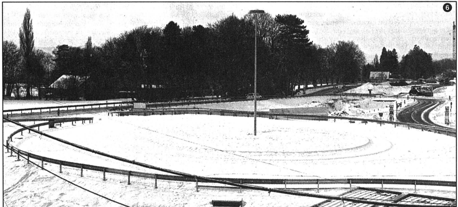
Photo 6: Le giratoire de Treytel servira d'accès à Bevaix dès que le revêtement bitumineux sera posé (c'est-à-dire dès que la
