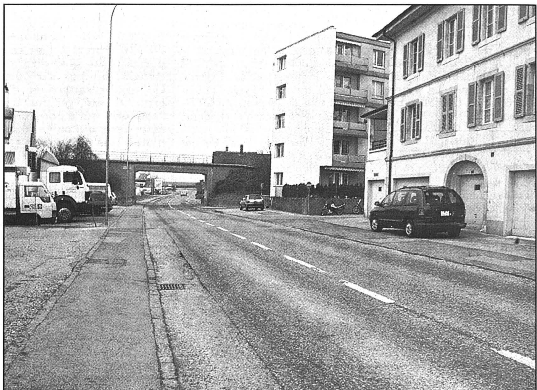
La rue des Indiennes, une fois réaménagée, illustrera la volonté d'harmonie entre trafic et piétons.
