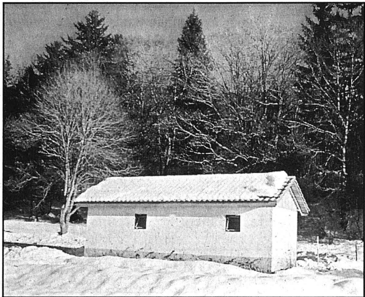
La station d'épuration du Pâquier pourrait mieux fonctionner si le consortium d'entreprises qui l'a aménagée avait maîtrisé les problèmes d'infiltration d'eaux claires dans le réseau de canalisations en amont. photo Leuenberger
