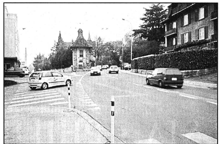
La future route d'évitement de Corcelles, qui doit partir de ce carrefour, ne fait pas l'unanimité. photo a
