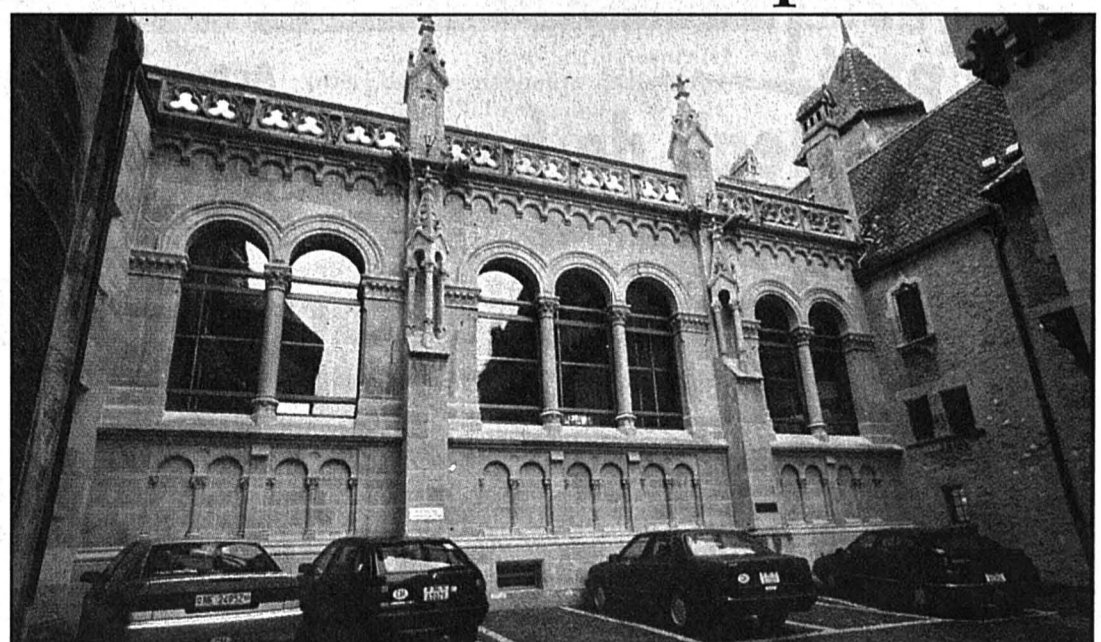
Les fenêtres sud ont été remplacées, notamment pour être davantage en harmonie avec les arcades arrondies de la façade. photo Galley
