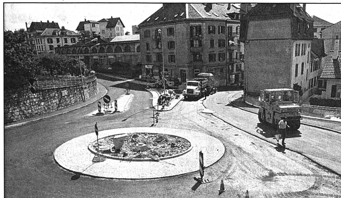
Au giratoire de Gibraltar, la couche d'usure vient d'être posée.
