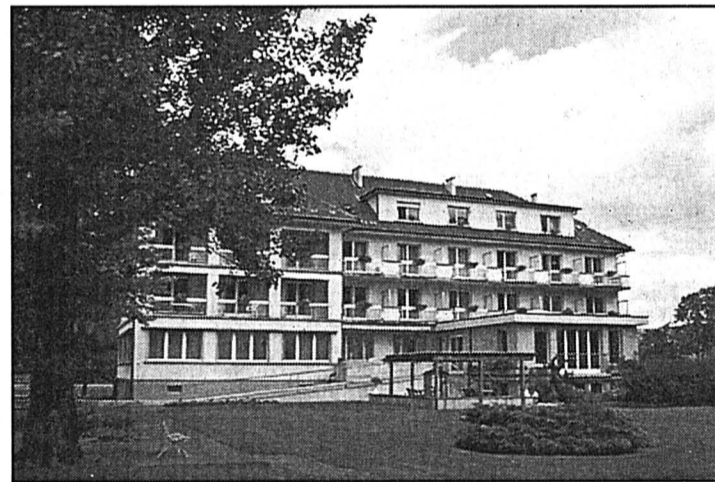
Le home Valfleuri, à Fleurier, inauguré en 1967, a été doté de nouvelles portes-fenêtres l'an dernier sur sa façade sud. photo De Cristofano
