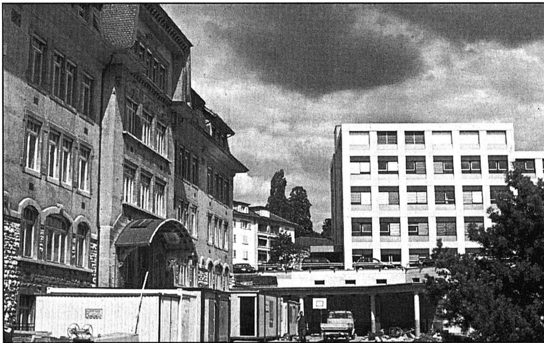
Le collège de la Maladière (à gauche) ne résisterait pas à une nouvelle extension du Csem (ici le bâtiment de la rue Jaquet-Droz). photo Marchon
