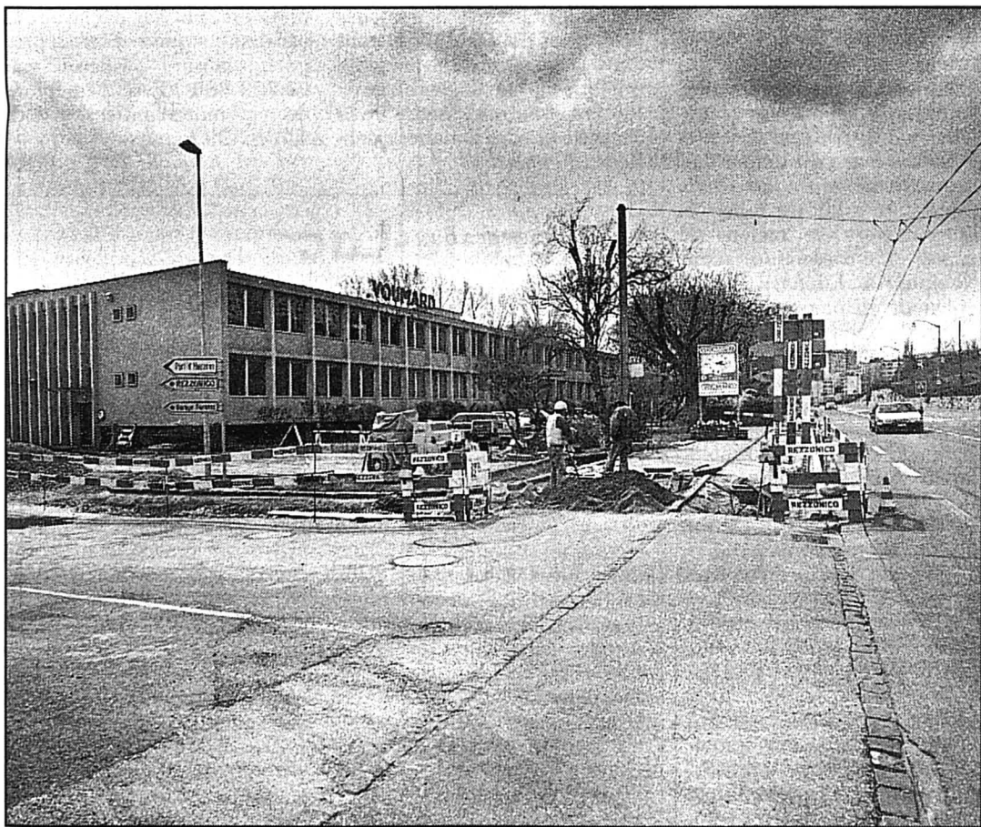
Un carrefour fort sollicité: en plus de l'accès au port et à l'usine Voumard, il faut prendre en compte les travaux qui conduiront à l'ouverture du futur Musée cantonal d'archéologie. photo Charrière
