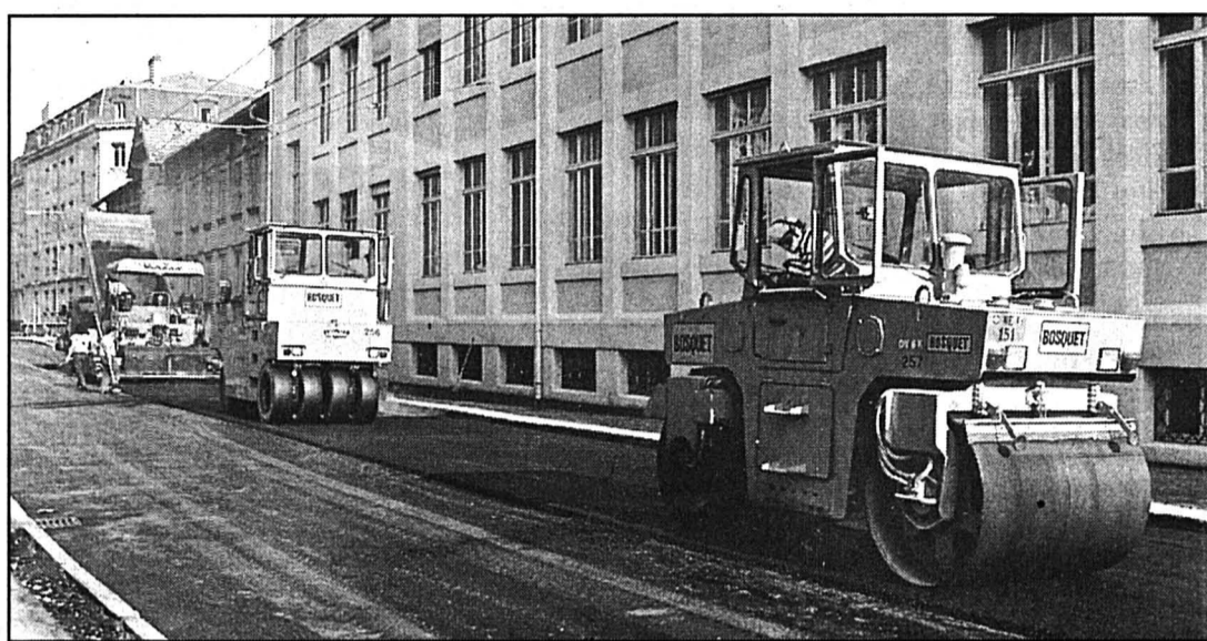
Le dépôt de bilan de l'entreprise Bosquet est un coup dur pour le secteur neuchâtelois de la construction. photo a
