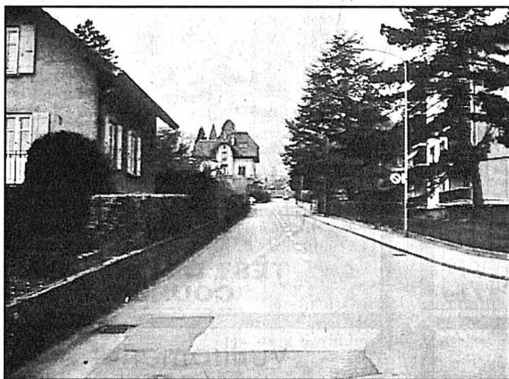
Si le Conseil général de Colombier donne son feu vert à un crédit de deux millions pour la construction d'un nouveau collecteur intercommunal, les travaux pourraient commencer dès ce printemps à la rue du Sentier. photo Radjo
