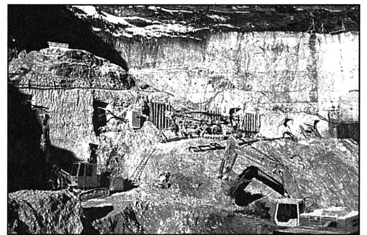
Le gros du terrassement devrait être achevé ce mois. photo Charrière
