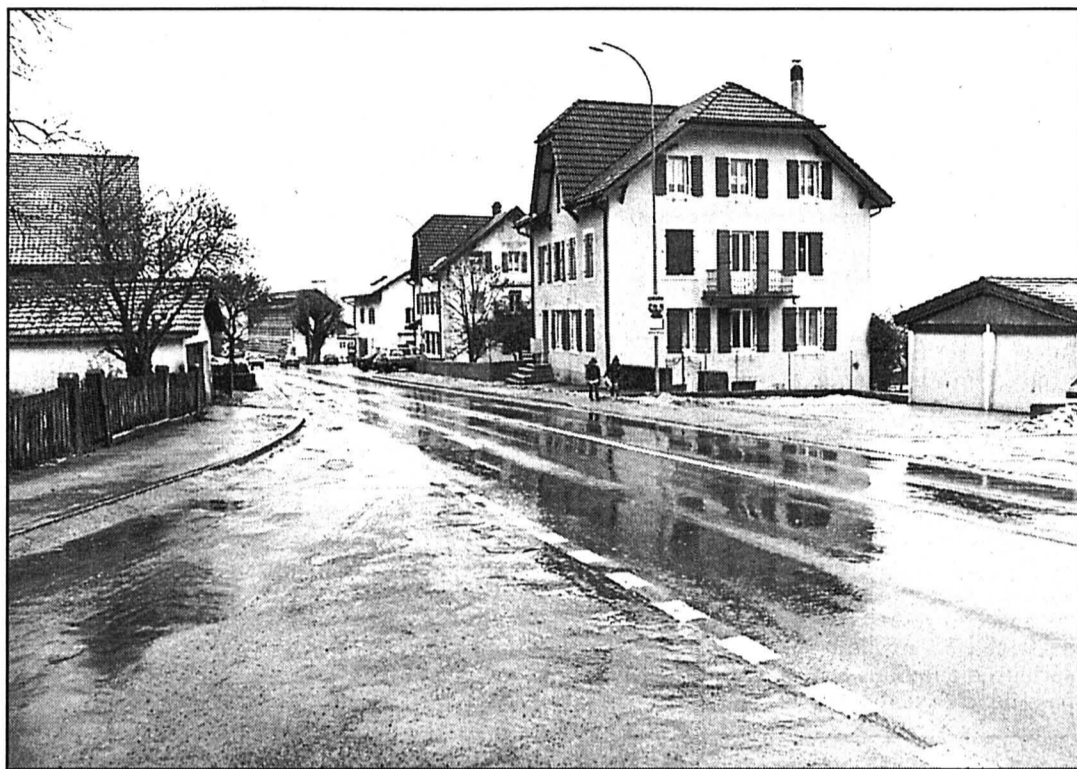
La Grand-Rue de Chézard-Saint-Martin sera rouverte au printemps, mais à l'ouest cette fois, pour d'importants travaux intercommunaux. La commune veut également profiter de la fouille.
