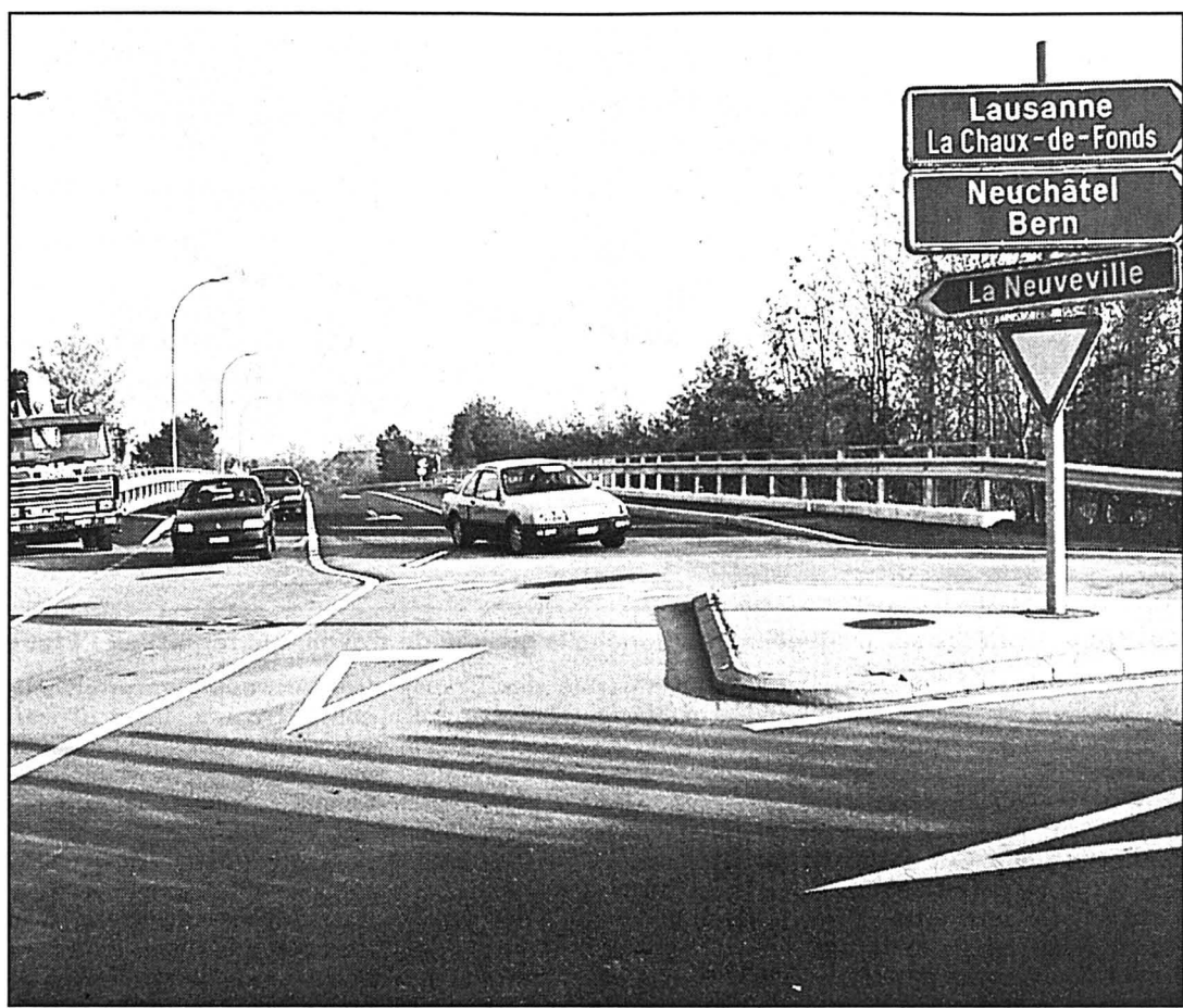
Après six mois de travaux, le pont des Flamands, étanche et résistant aux infiltrations de chlorure, a été ouvert à la circulation. photo Radja
