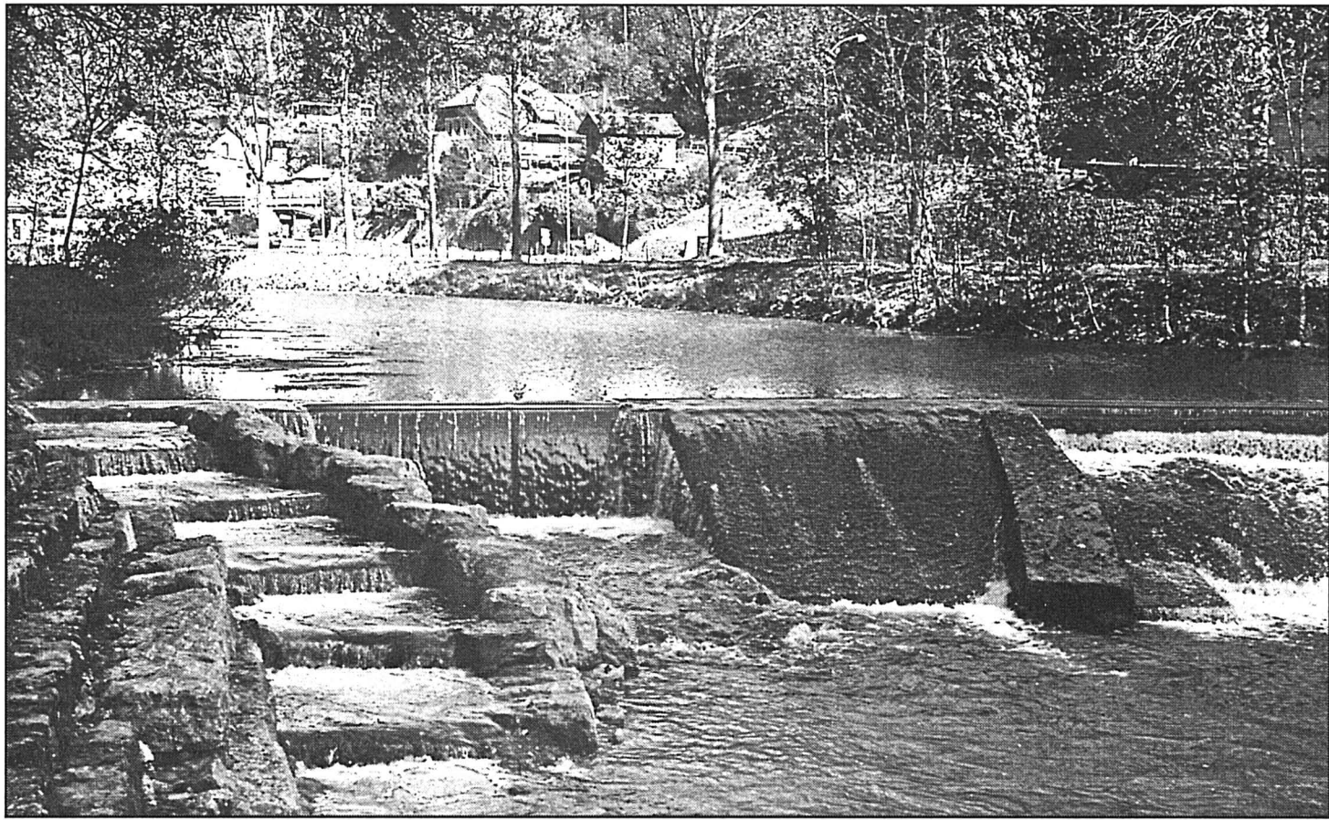
L'échelle à poissons, qui vient d'être construite à Saint-Sulpice, permet aux truites de frayer dans de meilleures conditions. photo De Cristofano
