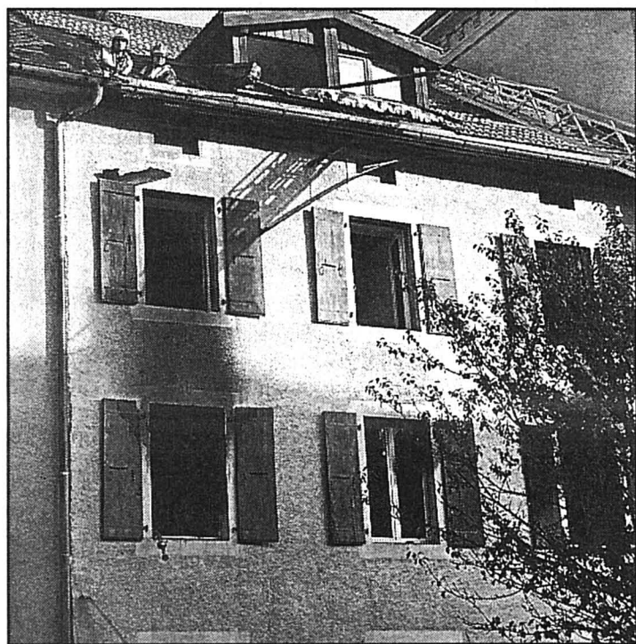
Le bâtiment, situé au numéro 1 de la rue du Jet-d'Eau, est inhabitable. photo Charrière
