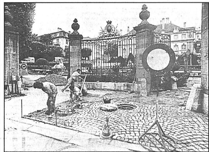
La surface pavée fait l'objet d'une réfection complète.
