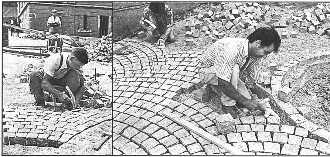
Le métier de paveur remonte à la nuit des temps. C'est sans doute la raison pour laquelle les techniques ne diffèrent guère d'une génération à l'autre. Dans les années 30, Dolfi Freiburghaus (photo de gauche), aujourd'hui, un ouvrier de l'entreprise.
