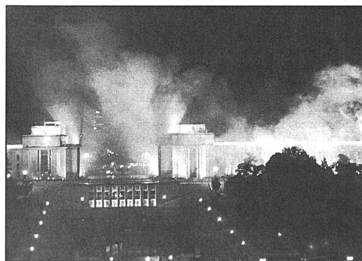
Le feu a surtout endommagé la toiture. photo AFP
