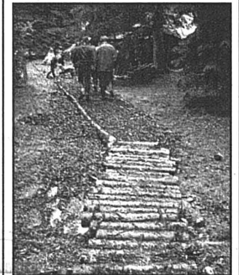
Trente stères de bois ont servi à monter les tentes et des passerelles.
