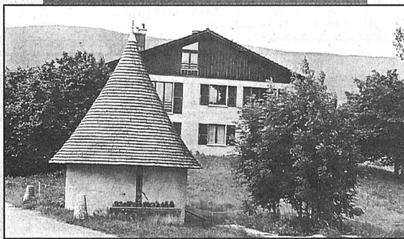
FRESENS - Le puits a subi une réfection en 1984./E
