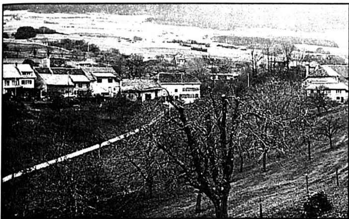
Fresens doit impérativement se relier à une station d'épuration. photo a
