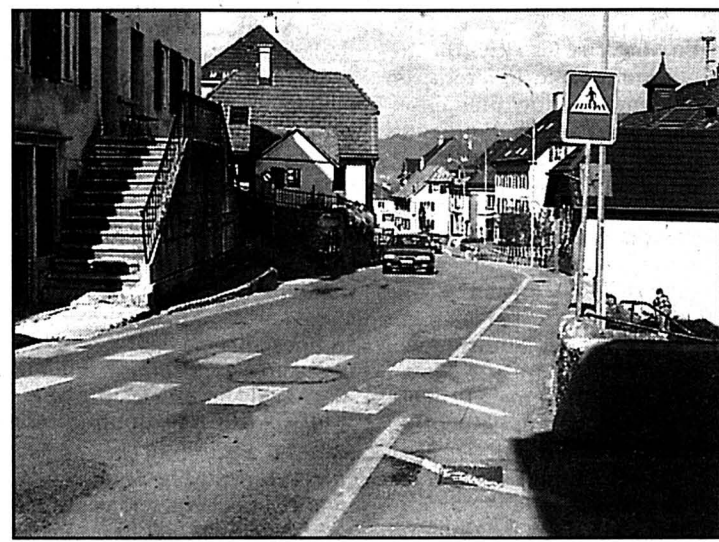
L'absence d'un véritable trottoir le long de la Grand-Rue préoccupe les autorités ponlières.
