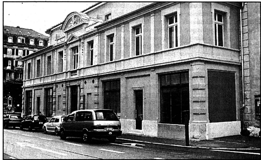
FAÇADE OUEST - Sa restauration a nécessité un travail minutieux et complexe pour retrouver le style d'origine.
