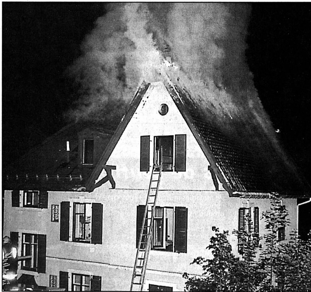
RUE DE L'HÔPITAL 2 — Tous les appartements, ravagés par les flammes ou sérieusement endommagés par l'eau et la mousse carbonique, sont inhabitables. jcp/E
