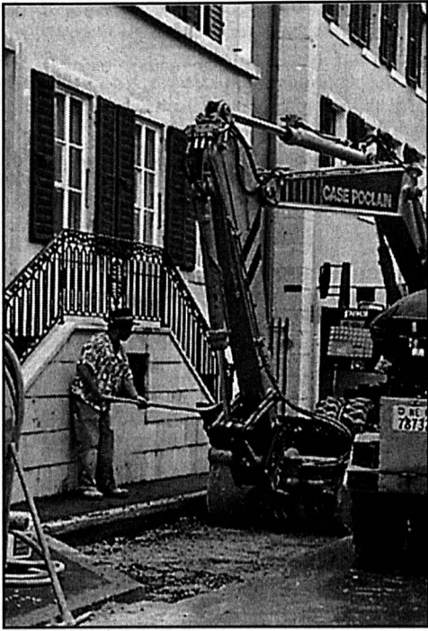
RUE DES ENVERS - Trop étroit, le trottoir est remodelé. jcp-E
