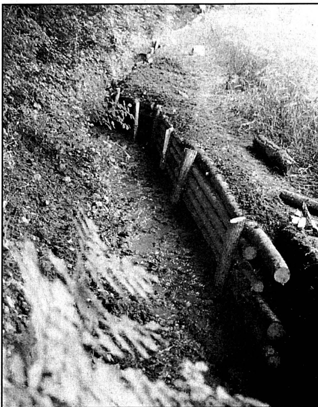
LES BERGES DU MORTRUZ - Les chômeurs qui ont renforcé les berges du ruisseau de Frochoux ont utilisé des matériaux naturels. Respect de la nature oblige, rondins et roches ont été préférés au béton.
