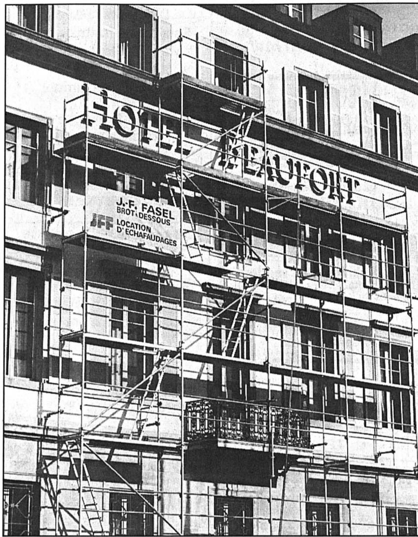
ENSEIGNE CONTESTÉE - Les échafaudages en témoignent: l'hôtel va changer d'appellation.
