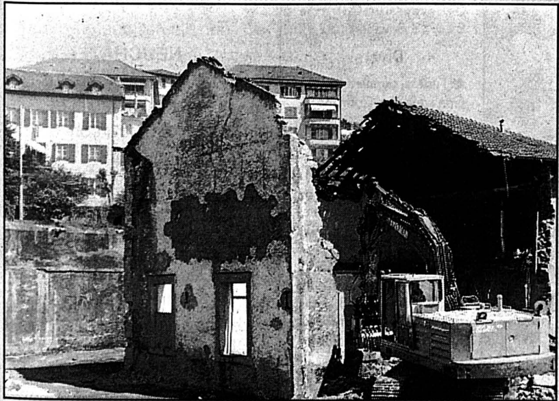
DÉMOLITION - Le nouveau bâtiment sera entièrement dédié à la formation artisanale. plr. E
