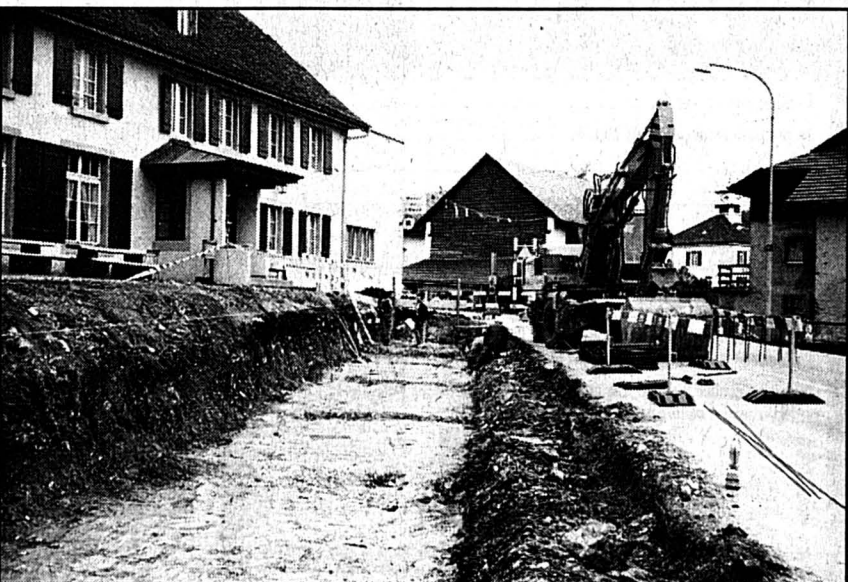
TRAVAUX - Un mur à niches viendra bientôt remplacer le vieux mur de pierres de taille.
