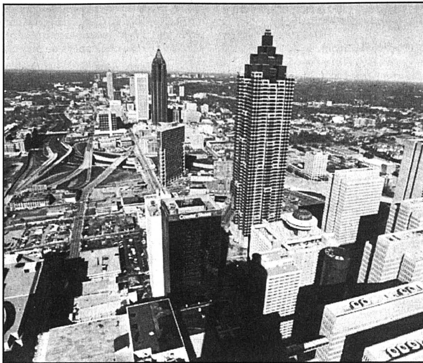
ATLANTA - A 100 jours des Jeux, la capitale de la Géorgie est encore un gigantesque chantier.
