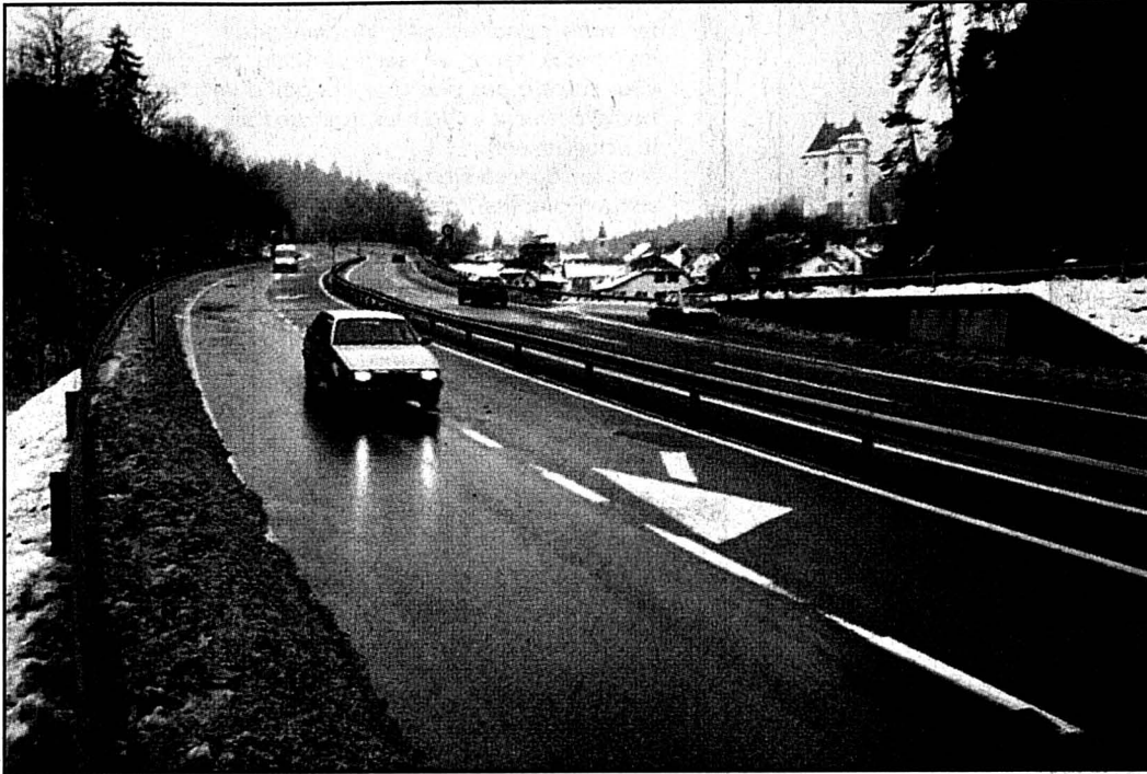
BAS DU PONT DE VALANGIN - Un giratoire y sera aménagé au mois d'avril, pour éviter que le trafic emprunte le village lors des fermetures complètes ou partielles de la route des gorges du Seyon.
