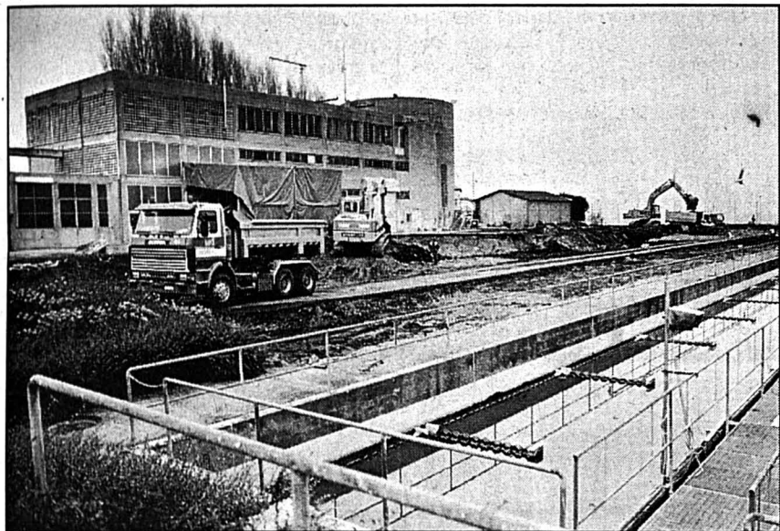
TRAVAUX DE TERRASSEMENT – Les nouvelles installations ne dépasseront pas les limites actuelles du site.
