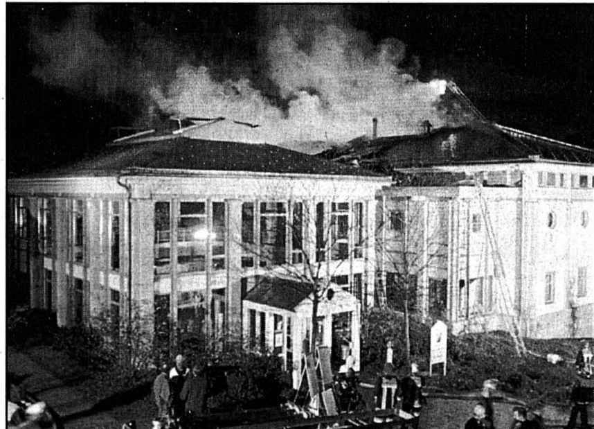
NOMBREUX DÉGÂTS - Un incendie s'est déclaré hier vers 14h40 dans le centre thermal Aquarena, à Schinznach-Bad (AG). Le toit du centre, qui abrite également un restaurant, était en train de brûler à l'arrivée des pompiers, a indiqué la police cantonale. Les dégâts sont estimés à plusieurs centaines de milliers de francs. Personne n'a été blessé. Les baigneurs ont pu quitter les lieux à temps. Le feu a pris dans un sauna. Il a été maîtrisé vers 17h. Une défectuosité électrique dans un solarium pourrait être en cause, a indiqué le directeur du centre Paul Fehr. Les pompiers de Brugg ont été appelés en renfort. Une centaine d'hommes sont intervenus. /ats
