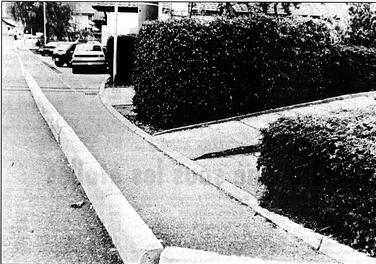
BORDURES - Au bas du petit escalier qui mène à la station de bus, des bordures ont été installées provisoirement pour tenir le trafic à une distance respectable des piétons. Elles dessinent aussi un couloir qui est dorénavant réservé aux marcheurs. pt. E
